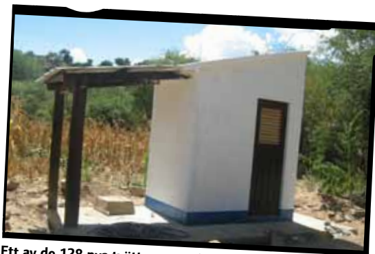
Ett av de 128 nya tvätterummen i Chinguri.
